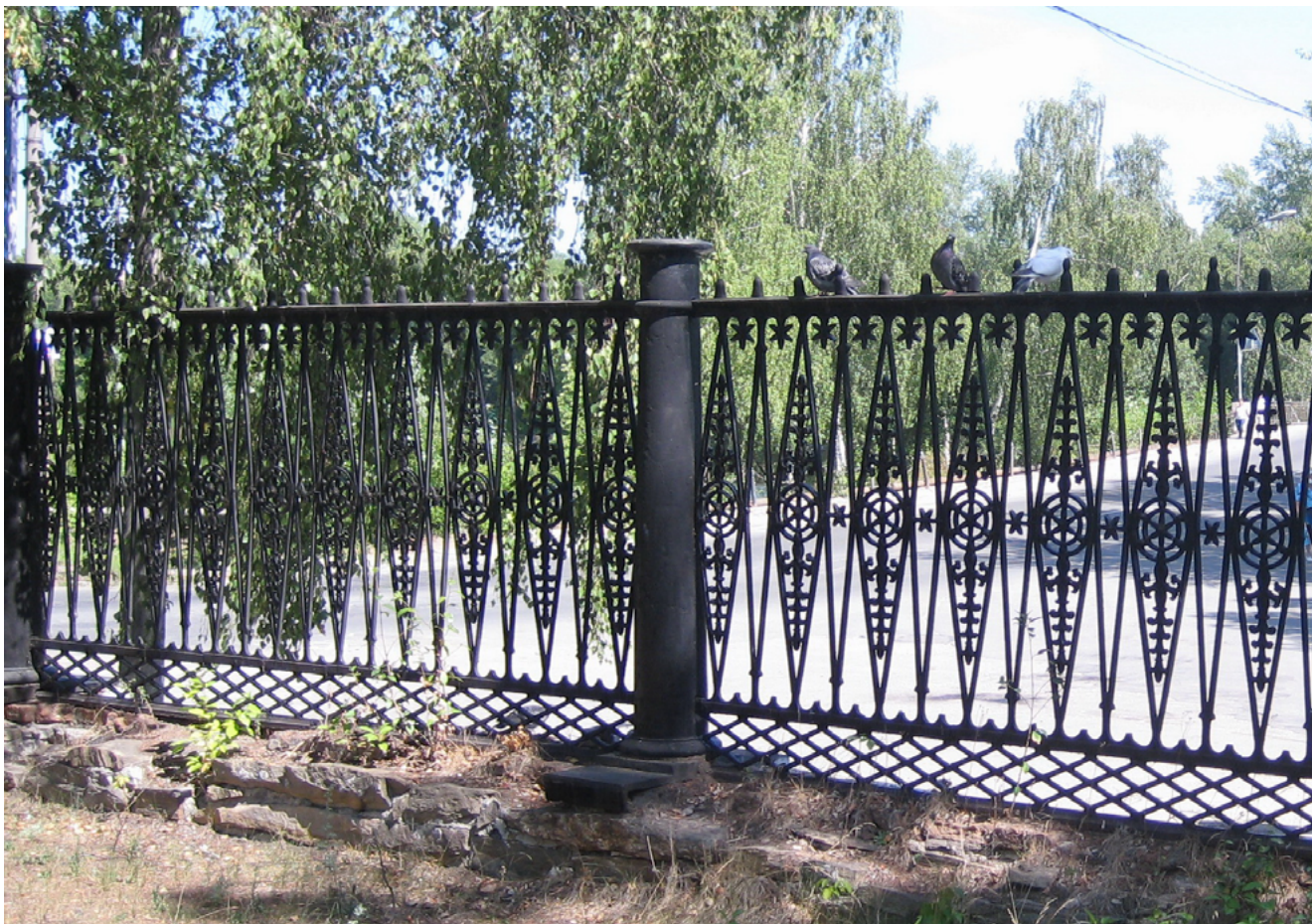
Илл. 11. Овальная чугунная ограда госпиталя Кыштымского завода. Современный вид. Несмотря на то, что у ограды отломаны практически все пики, а с колонн Тосканского ордера сбиты абак с шарами, ограда не утратила свой нарядный первоначальный вид Фото: В. Свиштунов
