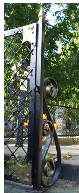
Илл. 10, 10а. Касли, городское кладбище. Сетчатая ограда на могиле Ощепковой. Ограда смонтирована на хорошо уложенных и прочно подогнанных друг к другу каменных блоках. Кованые столбики крепятся к блокам с помощью изящно изогнутых кованых полос с внутренней стороны ограды, тогда как в Петербурге аналогично изогнутые полосы, стоят с внешней стороны (Илл. 9). Фото: В. Свистунов
