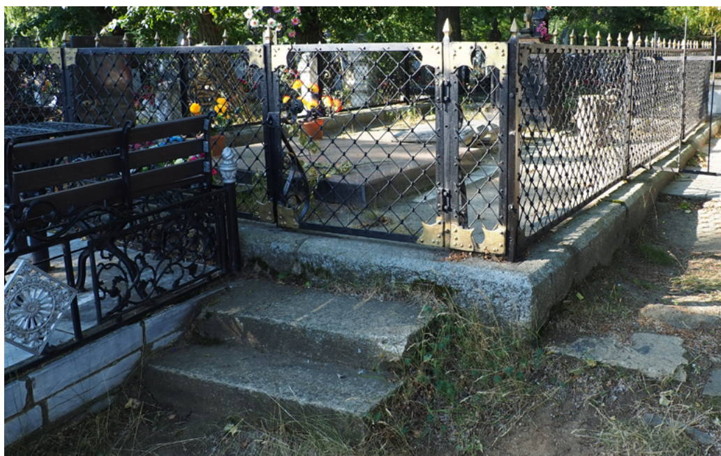
Илл. 10, 10а. Касли, городское кладбище. Сетчатая ограда на могиле Ощепковой. Ограда смонтирована на хорошо уложенных и прочно подогнанных друг к другу каменных блоках. Кованые столбики крепятся к блокам с помощью изящно изогнутых кованых полос с внутренней стороны ограды, тогда как в Петербурге аналогично изогнутые полосы, стоят с внешней стороны (Илл. 9). Фото: В. Свистунов
