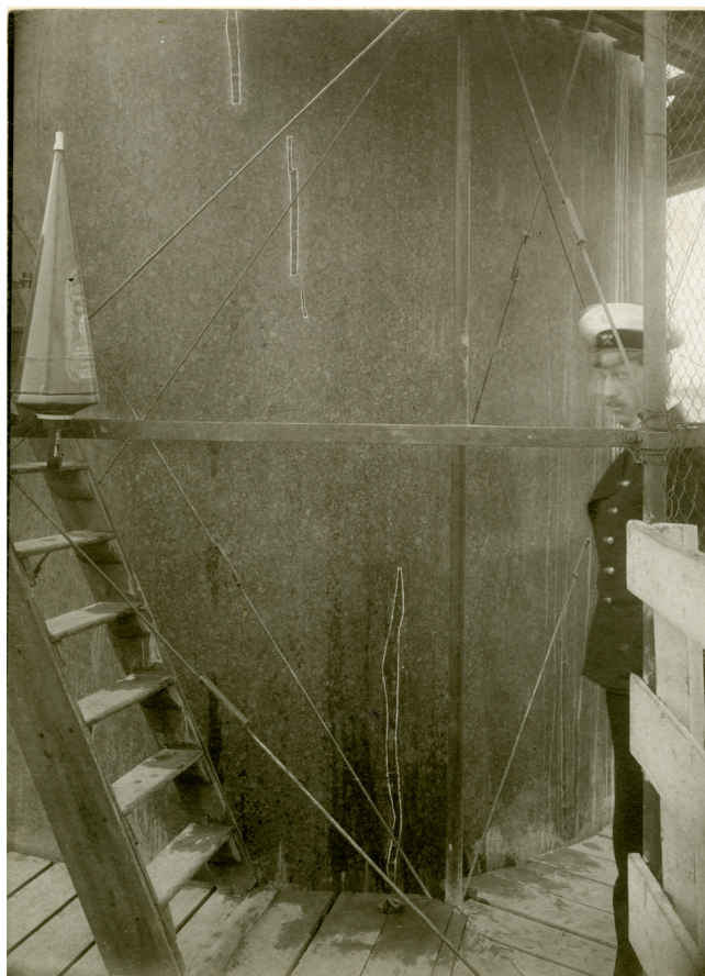
Илл. 11. Фотография. Вид части Александровской колонны в строительных лесах. 1910–1912. РГИА, Санкт-Петербург
