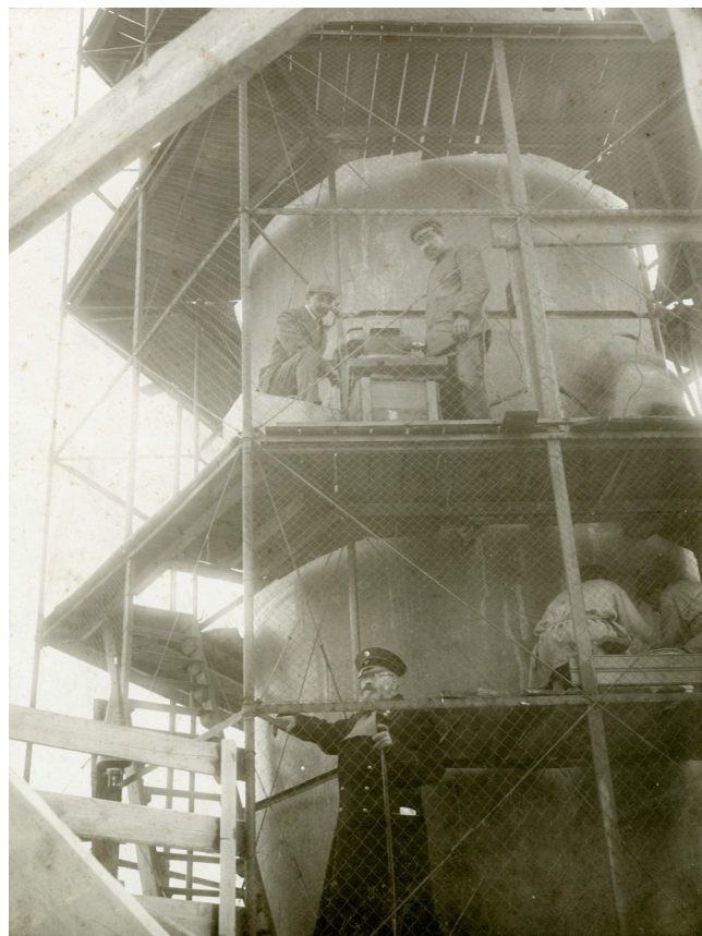
Илл. 10. Фотография. Вид части Александровской колонны в строительных лесах. 1910–1912. РГИА, Санкт-Петербург
