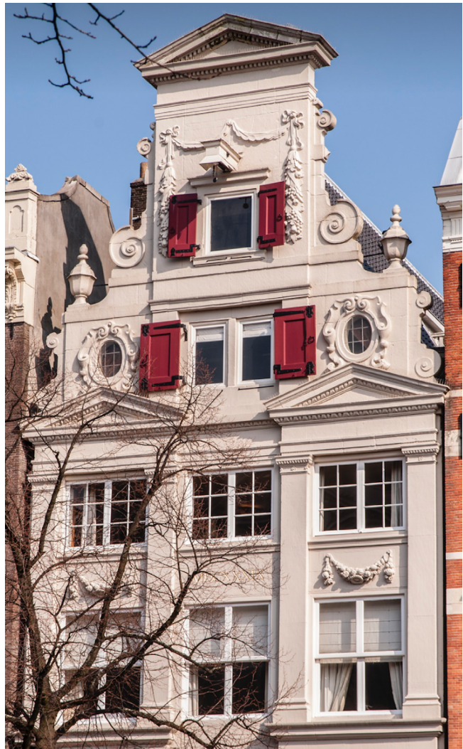
Илл. 11. Ф. Вингбонс. Дом Дэниеля Сойера. Фасад. 1640. Амстердам, Нидерланды
